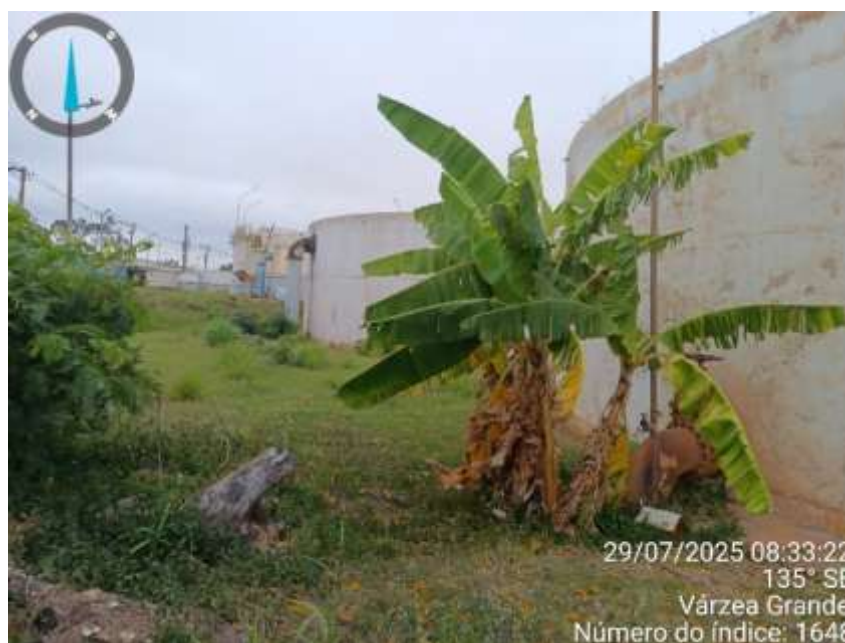
Figura 189: Centro de Reservação – ETA Júlio Campos
