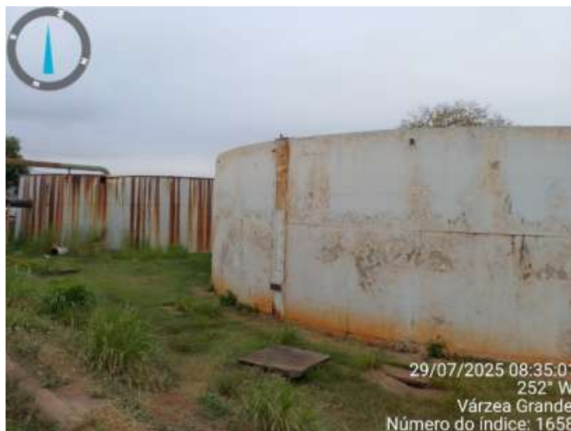
Figura 190: Reservatórios Metálico e de Concreto
