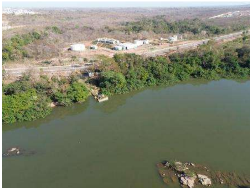
Figura 52: Vista Aérea da Captação da ETA Barra do Pari
