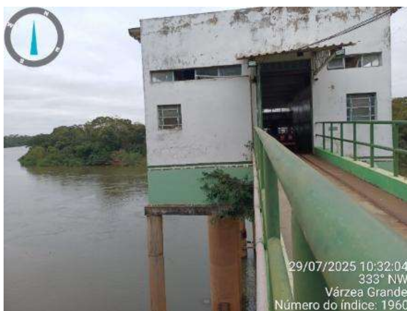
Figura 40: Casa de Bombas da Estação Elevatória de Água Bruta
