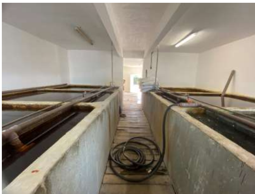
Figura 179: Tanques de Solução
