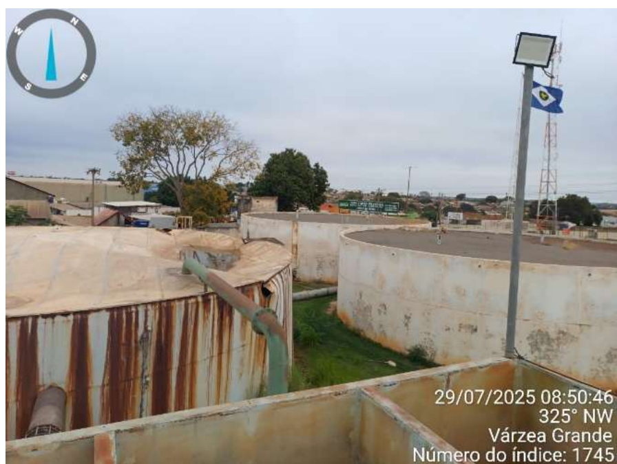
Figura 187: Vista Superior dos Reservatórios Apoiados
