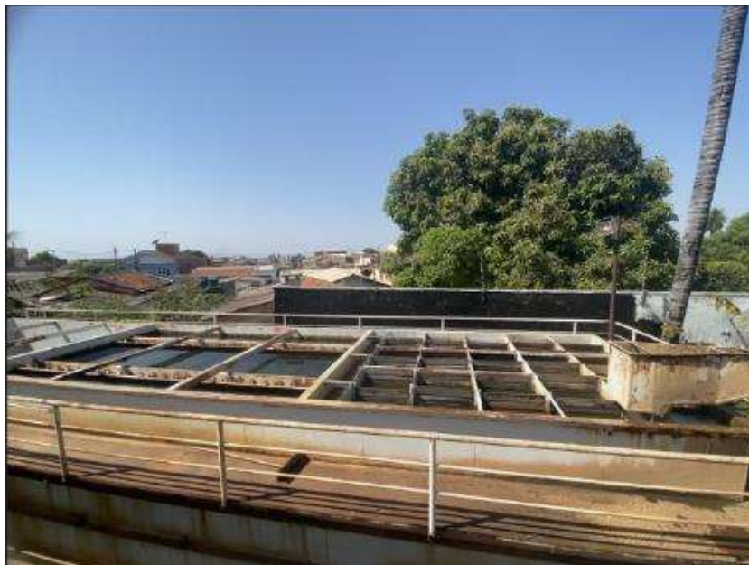
Figura 77: ETA 3 – Floculadores, Decantadores e Filtros
