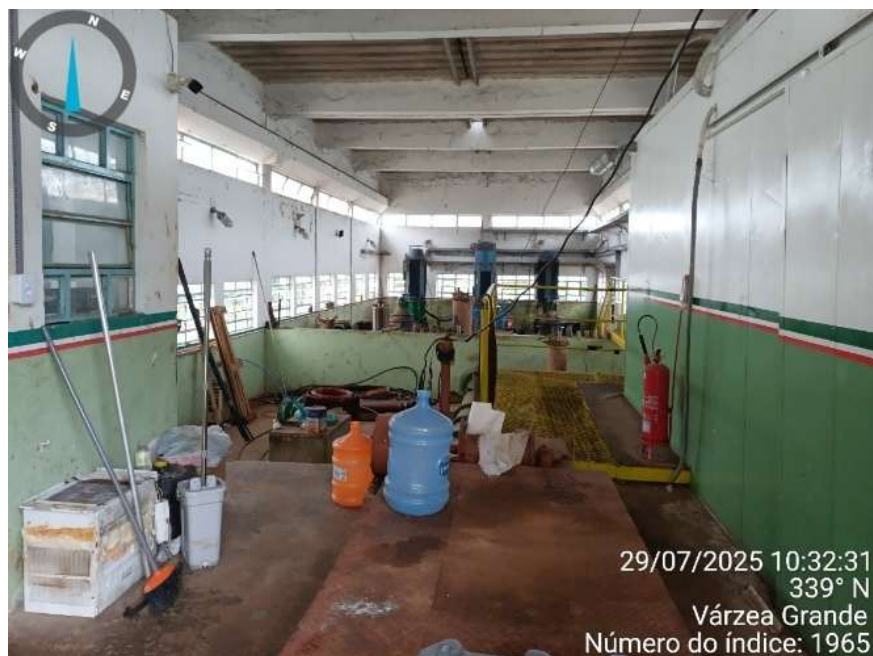
Figura 41: Casa da Estação Elevatória de Água Bruta
