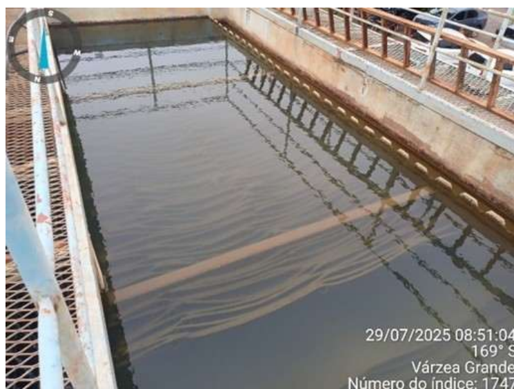
Figura 105: ETA 1 – Decantador
