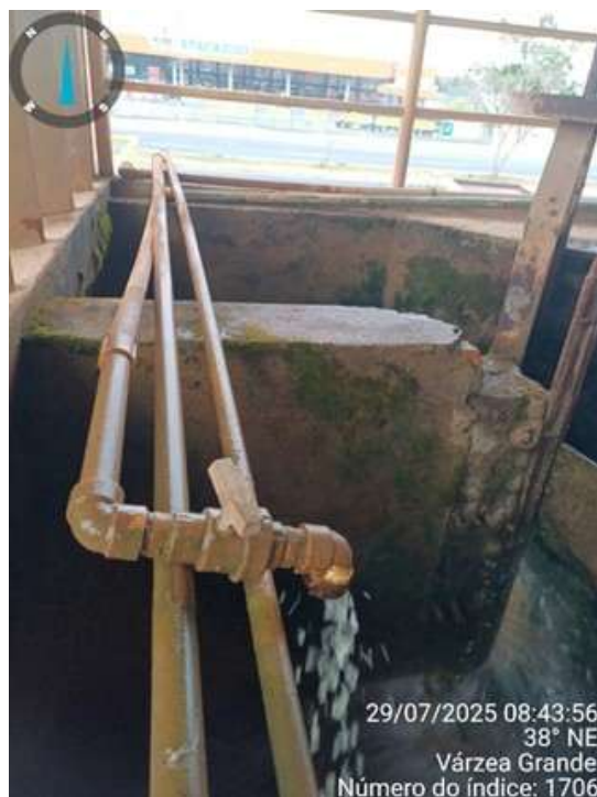
Figura 103: Dosagem de Calha Parshall
