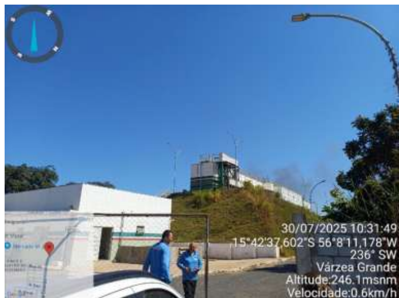
Figura 168: Vista da Entrada da Estação de Tratamento
