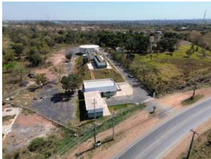
Figura 166: Área da ETA dos Imigrantes – Vista Aérea
