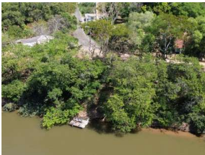
Figura 55: Vista Aérea da Captação de Bom Sucesso
