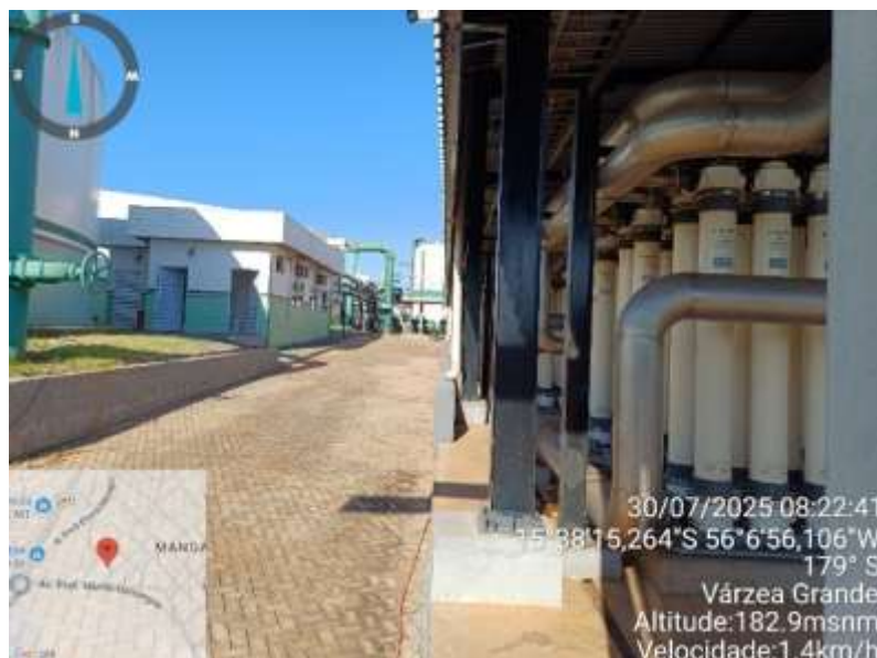
Figura 131: Galpão e Laboratório de Controle e Qualidade – Vista Parcial
