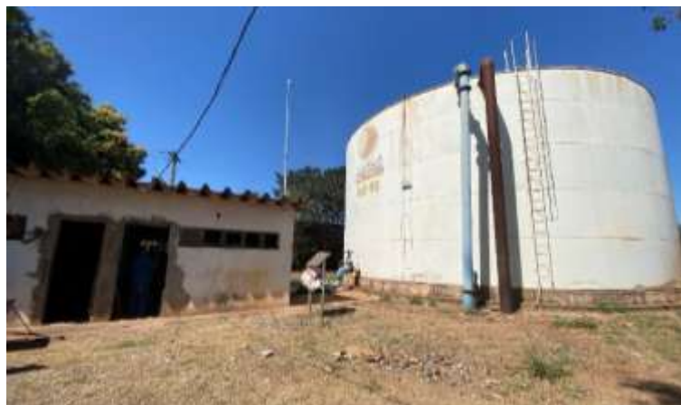
Figura 191: Casa de Bombas e Reservatório Apoiado de 1.000 m 3
