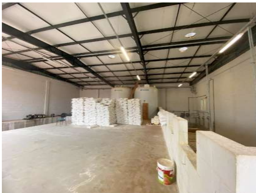
Figura 152: Casa de Química – Estocagem de Produtos Químicos (02 Imagens)
