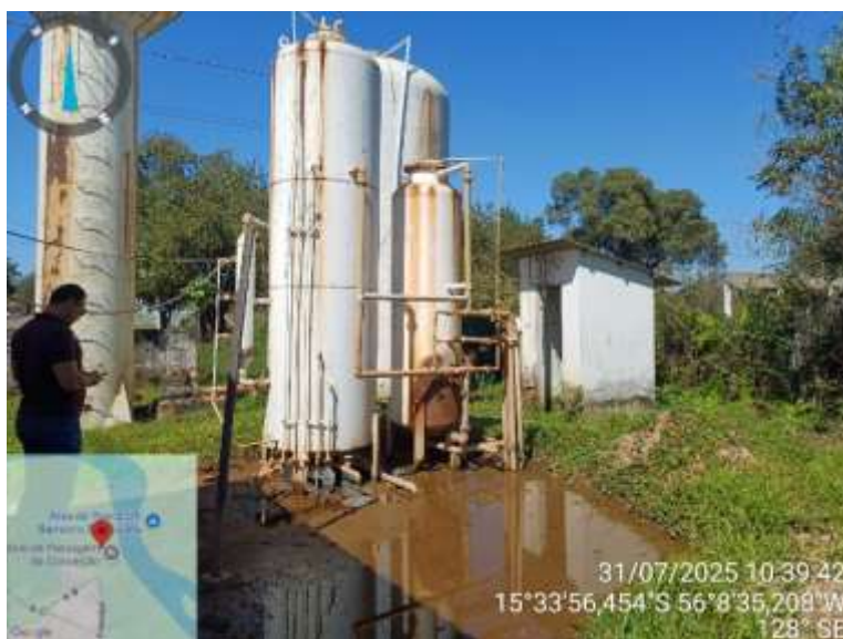
Figura 181: ETA Compacta Fechada
