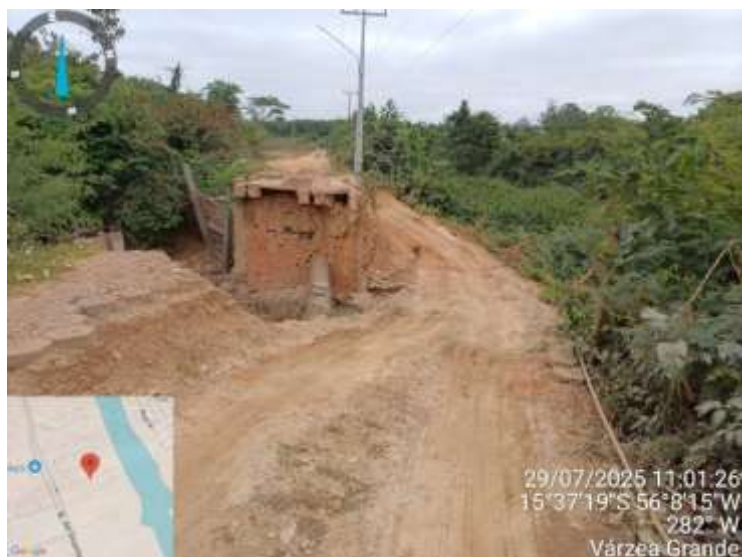
Figura 46: Estrada de Acesso e AAB a Céu Aberto
