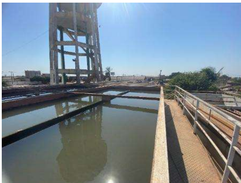
Figura 76: ETA 2 – Decantadores
