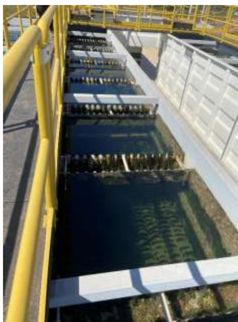
Figura 171: Decantador
