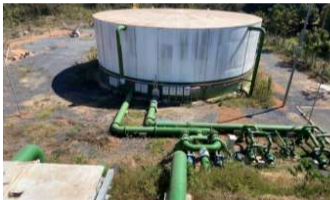
Figura 197: Reservatório dos Imigrantes
