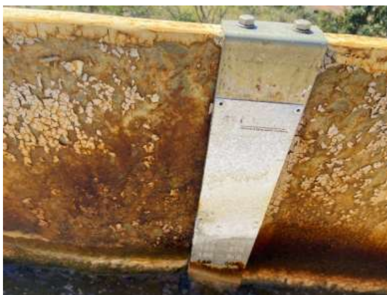
Figura 169: Régua da Calha Parshall - Medidor de Vazão
