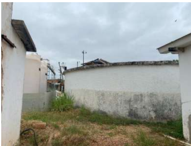
Figura 185: RAP 300 m 3 - ETA 1 – Desativado
