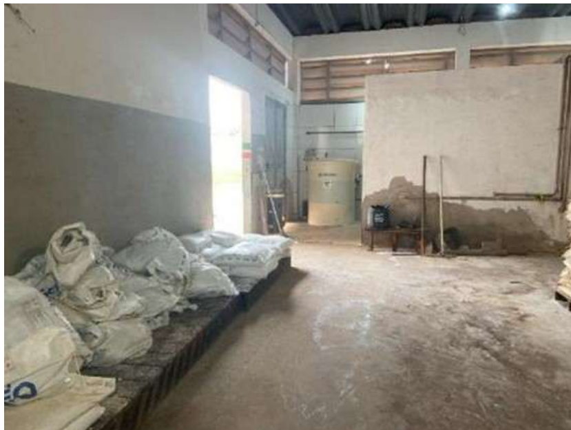
Figura 98: Produtos Químicos e Tanque de Preparo de Soluções
