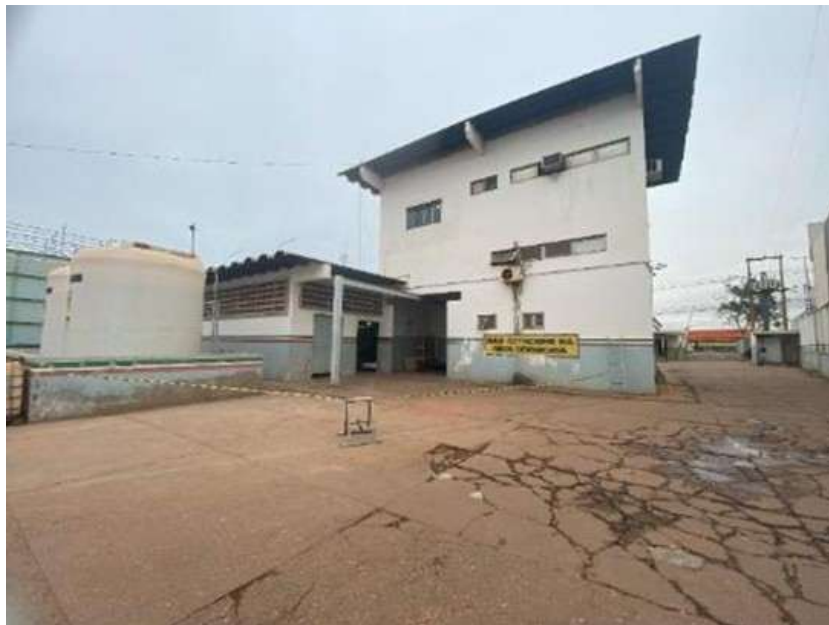
Figura 96: Vista Externa da Casa de Química
