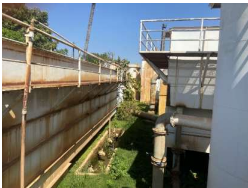
Figura 78: ETA 3 – Caixa de Descarga
