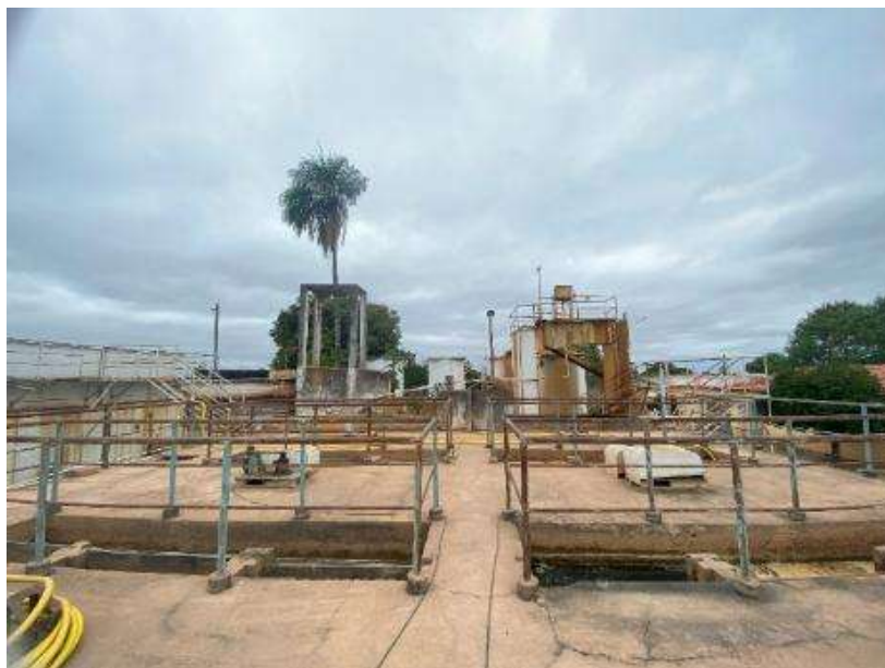
Figura 68: ETA 1 – Vista para a Calha Parshall
