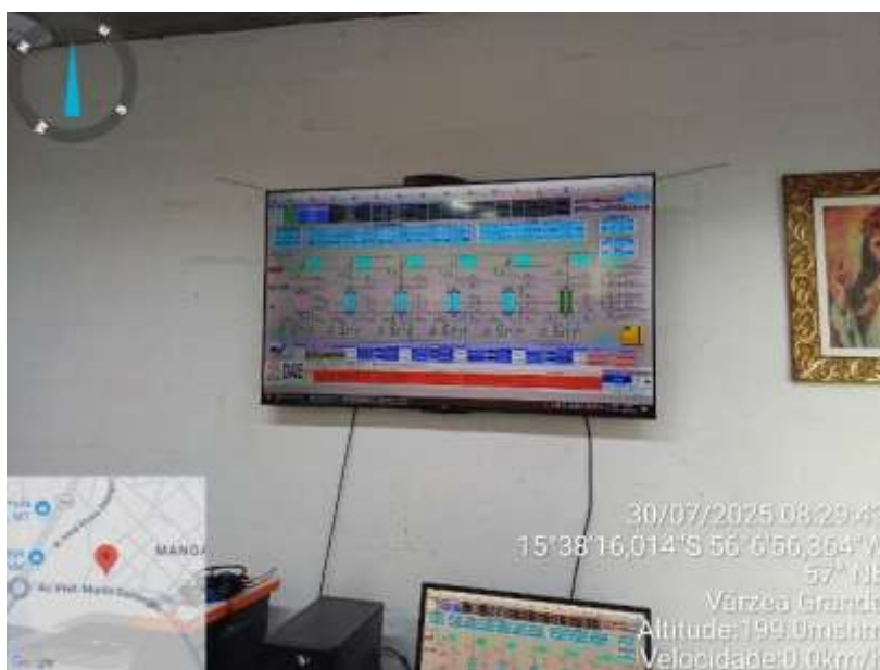
Figura 142: Tela com Supervisório da ETA Cristo Rei em Operação
