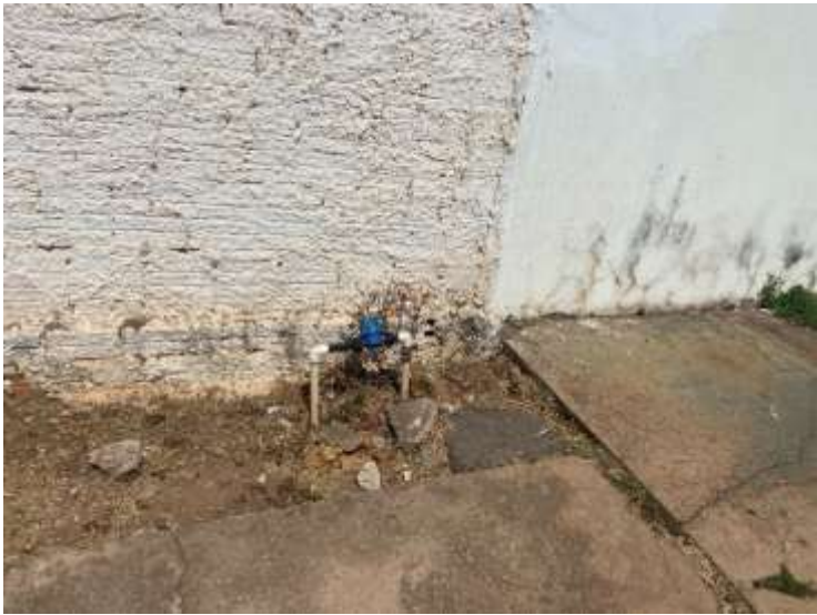
Figura 204: Ligação Predial com Hidrômetro
