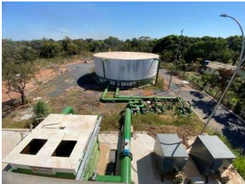
Figura 176: Reservatório Apoiado e EEAT 13
