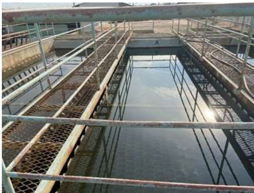
Figura 117: ETA 2 – Decantadores
