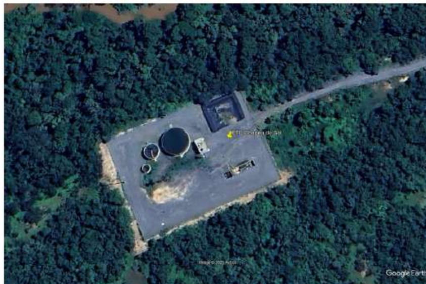
Figura 217: ETE Chapéu do Sol
