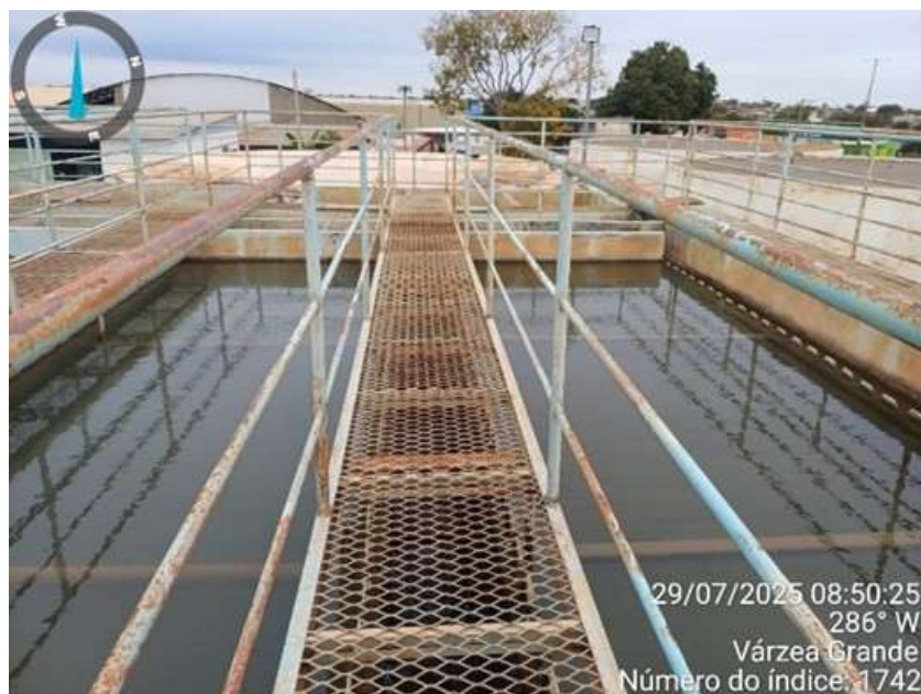
Figura 108: ETA 1 – Decantador, Passarela e Guarda-Corpo
