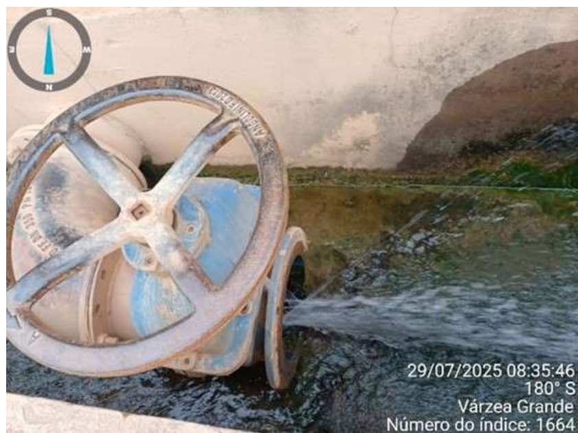
Figura 111: Registro de Descarga
