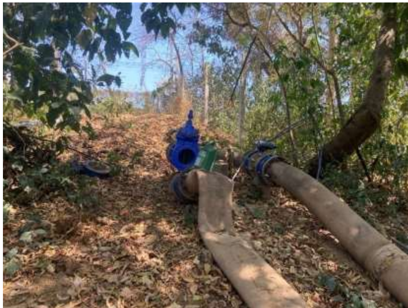
Figura 50: Mangote Flexível do Barrilete de Recalque
