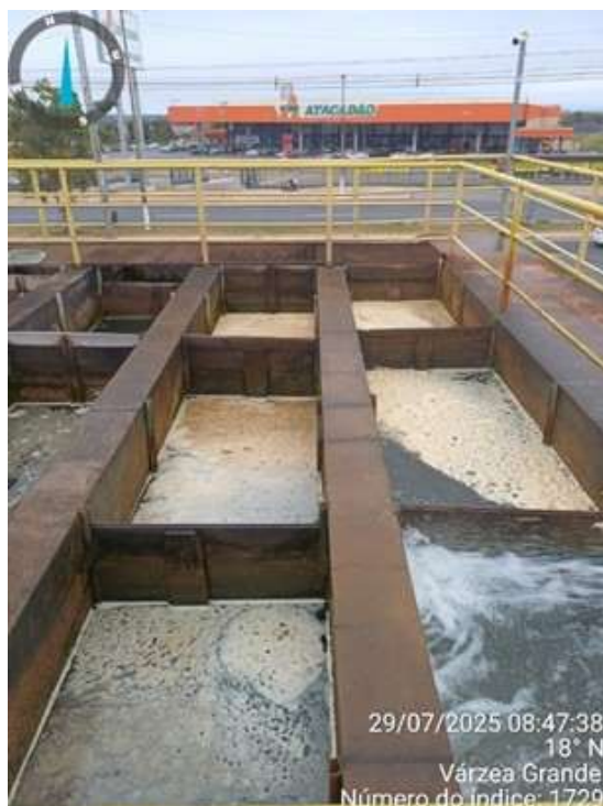
Figura 106: ETA 1 – Floculador
