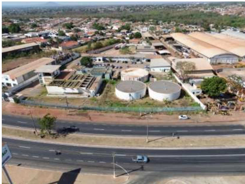
Figura 92: Vista Aérea da ETA Júlio Campos
