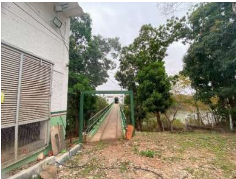
Figura 39: Passarela de Acesso à Captação de Água Bruta
