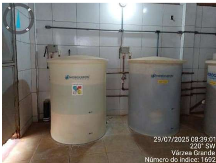
Figura 100: Tanque de Preparo de Soluções
