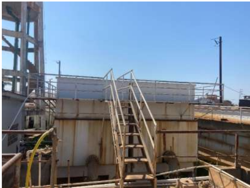
Figura 75: ETA 2 – Acesso aos Decantadores
