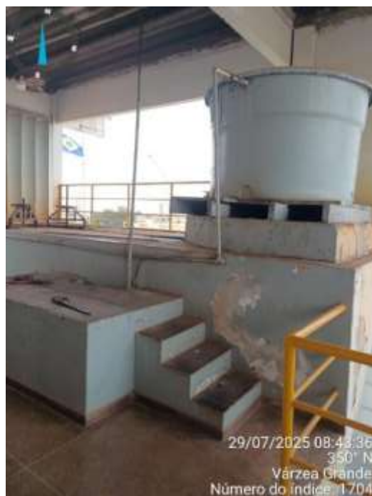
Figura 101: Piso Superior – Casa de Química e Calha Parshall
