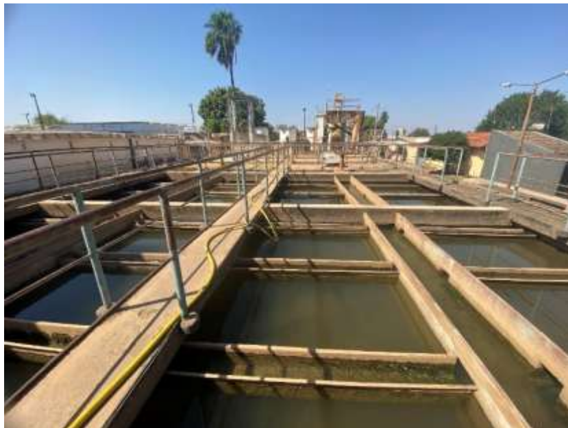
Figura 71: ETA 1 – Decantadores
