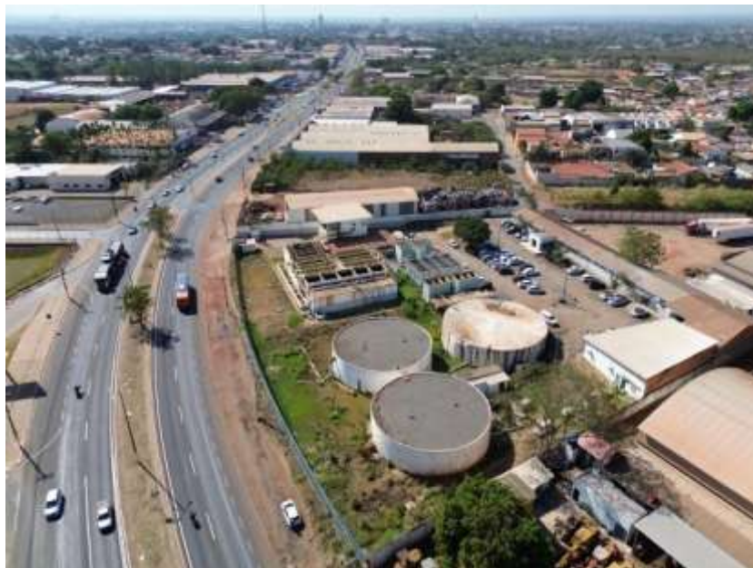
Figura 94: Vista Aérea da ETA Júlio Campos
