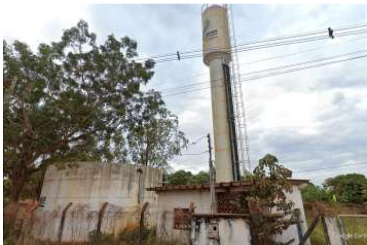
Figura 199: Reservatórios Vitória-Régia I e II
