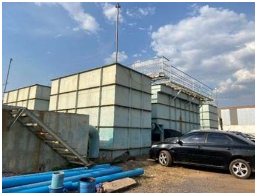
Figura 116: ETA 2 – ETA Metálica
