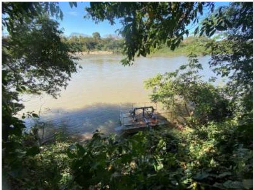
Figura 56: Unidade Flutuante e EEAB
