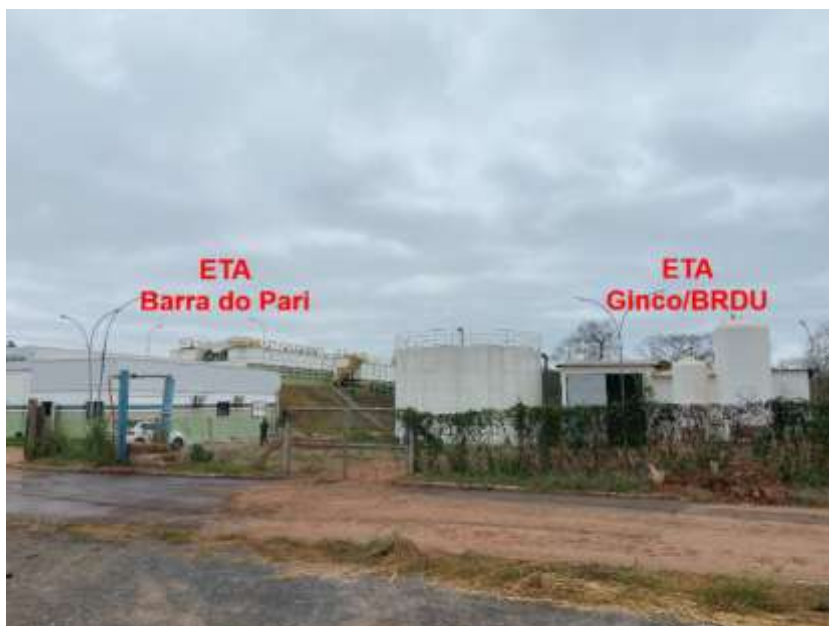
Figura 148: Frente da Área das Estações de Tratamento de Água
