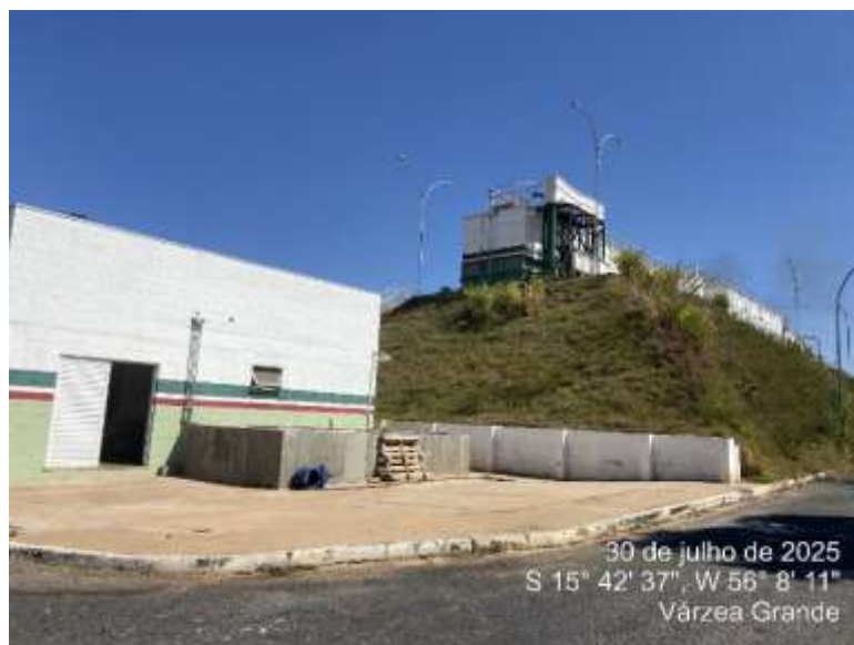
Figura 170: Vista da ETA e da Casa de Química
