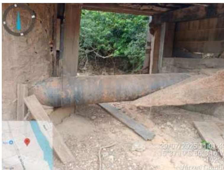
Figura 47: Trecho da AAB Embaixo da Antiga Ponte de Madeira
