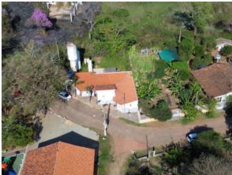
Figura 180: ETA de Passagem da Conceição
