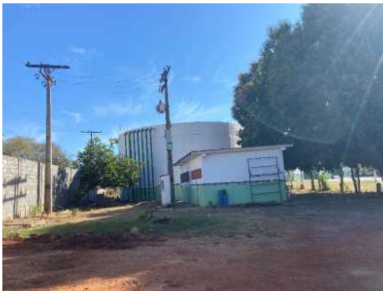
Figura 193: Reservatório Parque do Lago
