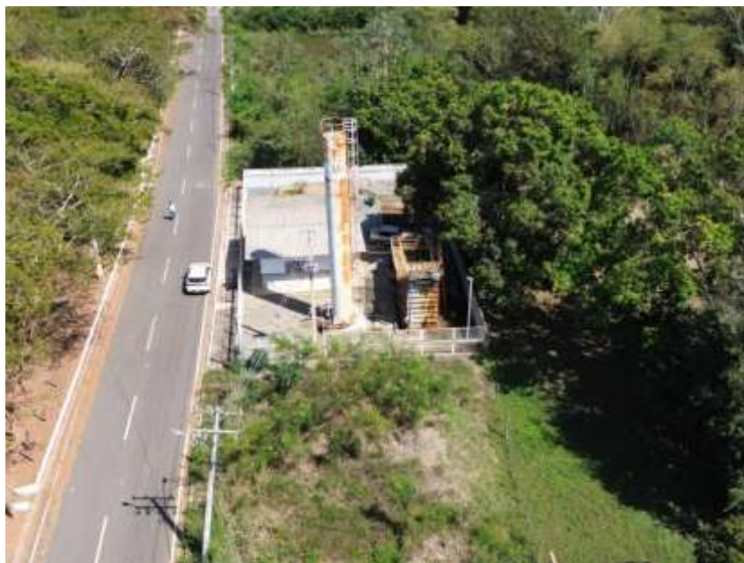
Figura 156: Área da ETA de Bom Sucesso – Vista Aérea
