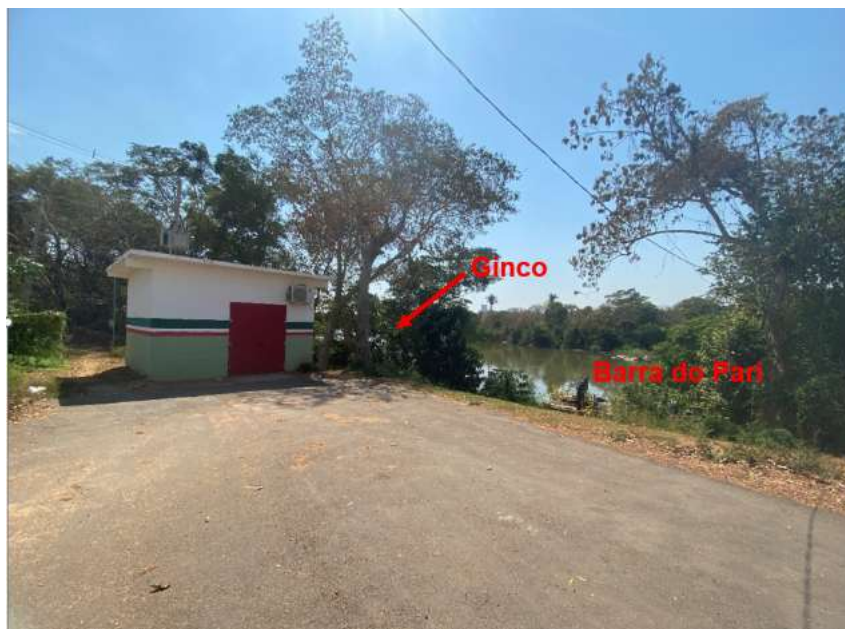
Figura 53: Barra do Pari/Casa de Comando Elétrico
