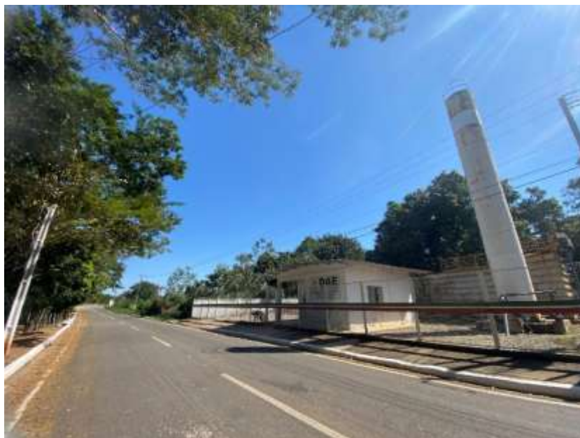
Figura 158: ETA de Bom Sucesso – Vista da Área
