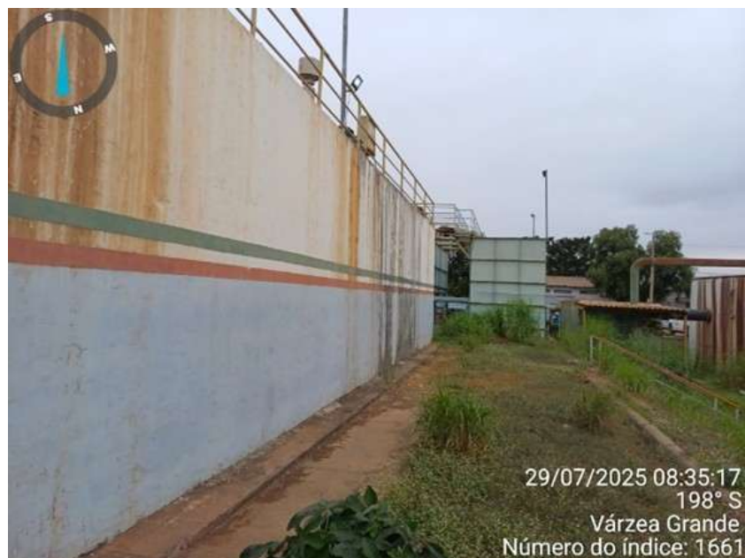
Figura 110: ETA 1 – Parede Lateral e Calçada
