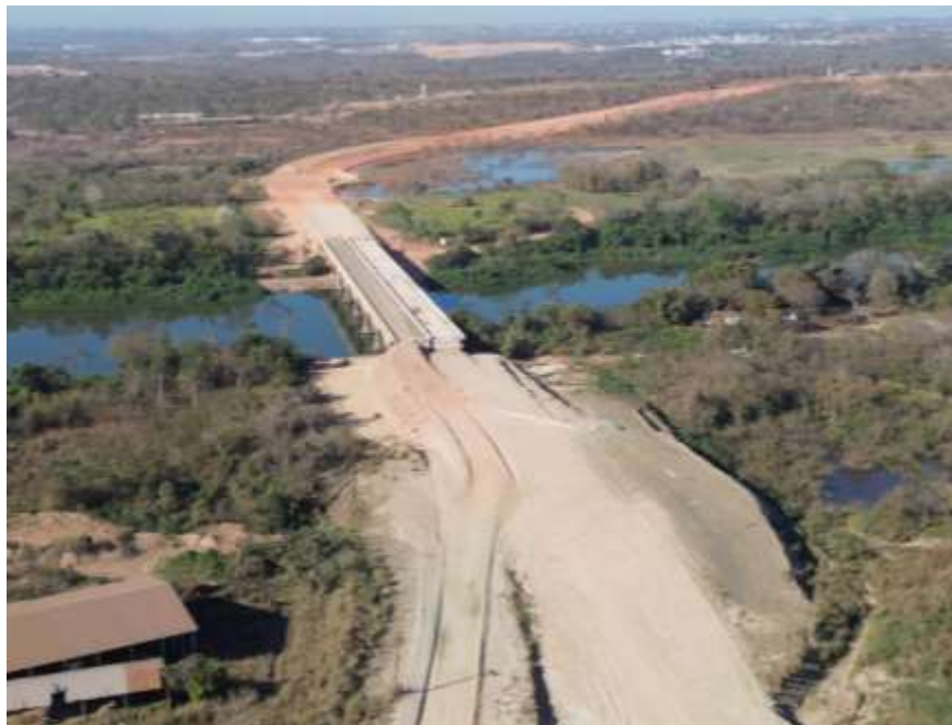
Figura 5: Ponte Rodoanel (Em Construção)
